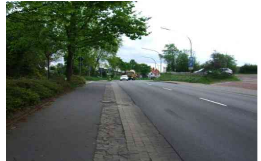
L81 im Ortseingangsbereich von Bohmte
