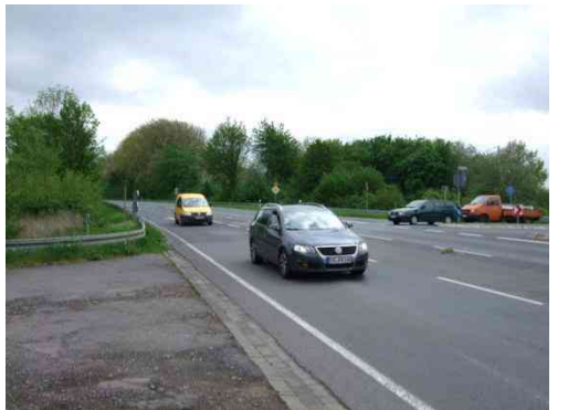
Bad Essen - Problematische Knotenpunkte im Zuge der B65 (KP B65/K410)
