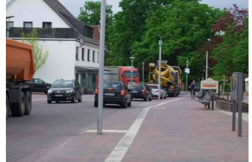
Ortsdurchfahrt Bohmte (Bremer Straße)
