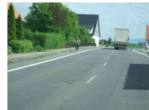
Radfahrstreifen entlang der B65 im Bereich Dahlinghausen
